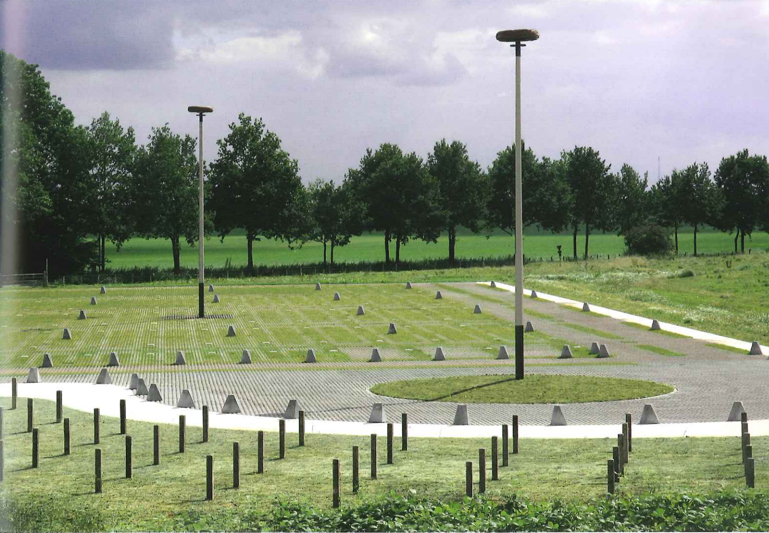
De busrotonde, betonnen fietspalen en als ooievaarsnesten gecamoufleerde lichtmasten
